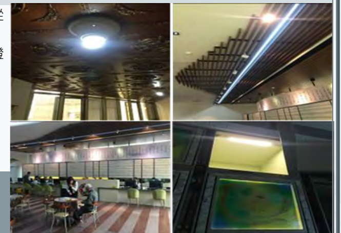
更換 LED 照明設備
